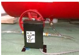
【CO 2 レシーバタンク取付設置例】
