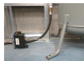
【レシーバータンク取付設置例】
